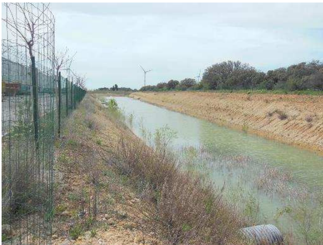
Figure 28 : Photographie du bassin de rétention Sud (volume de 33 000 m 3 )
