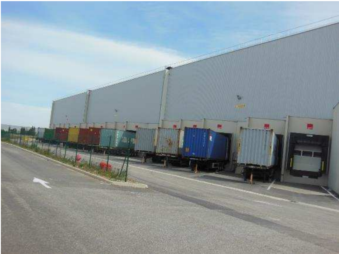
Figure 5 : Photographie du bâtiment B et des cellules 1, 2 et 3
