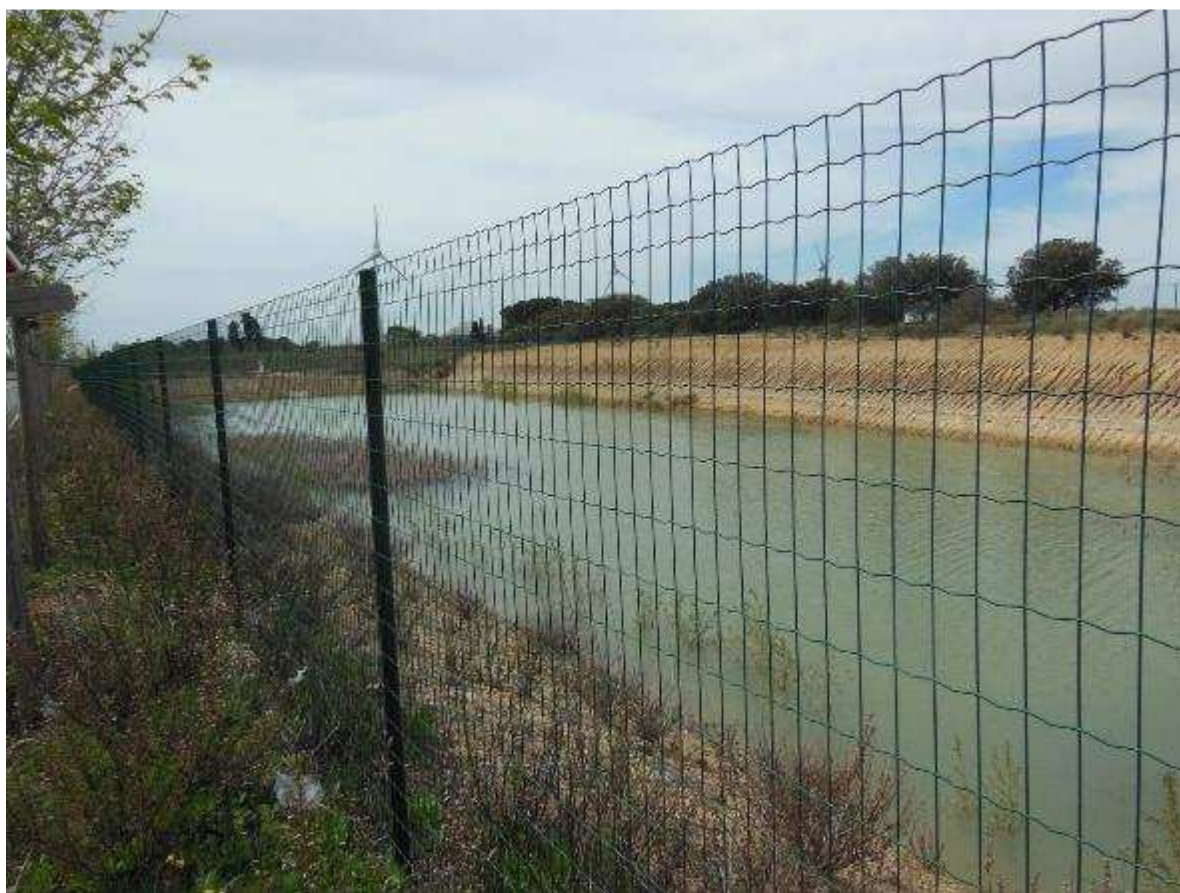
Figure 4 : Photographie du bassin d'infiltration sud déjà réalisé avec sa clôture d'enceinte
